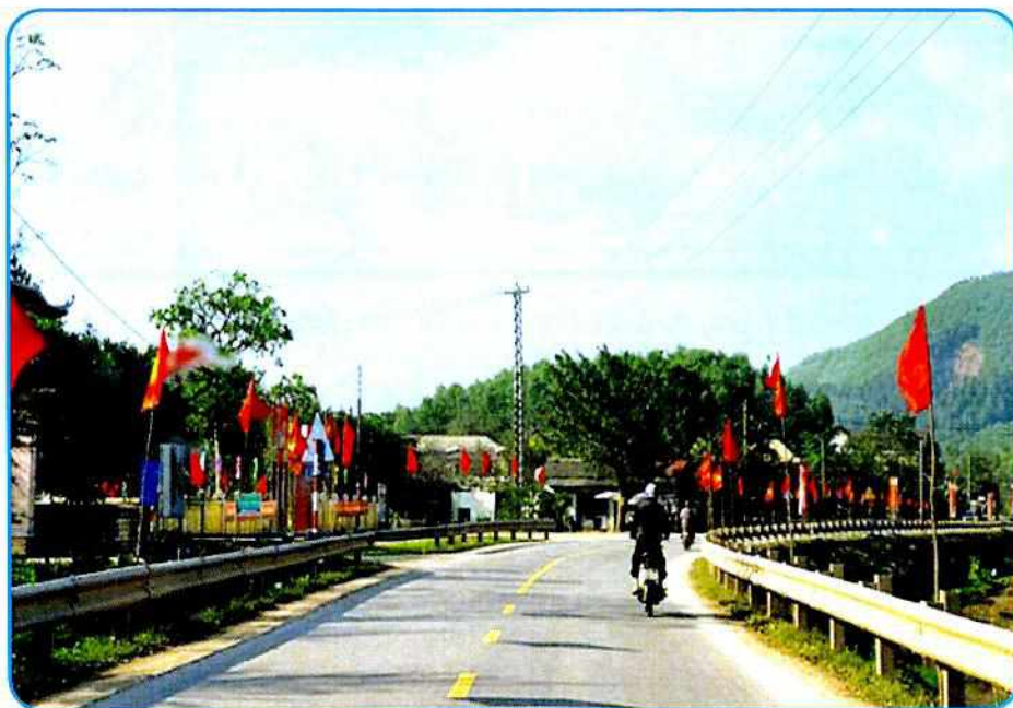
Hình 6.2. Một đoạn Quốc lộ 12A
