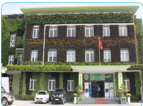
Hình 8.4. Công trình thí điểm Màng xanh đứng và vườn trên mái tại toà nhà Ban Quản lý Dịch vụ Công ích thành phố Đồng Hới
