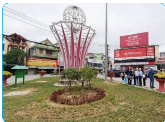
Hình 8.5. Hệ thống thoát nước đô thị bền vững tại ngã ba Bắc Lý, thành phố Đồng Hới
